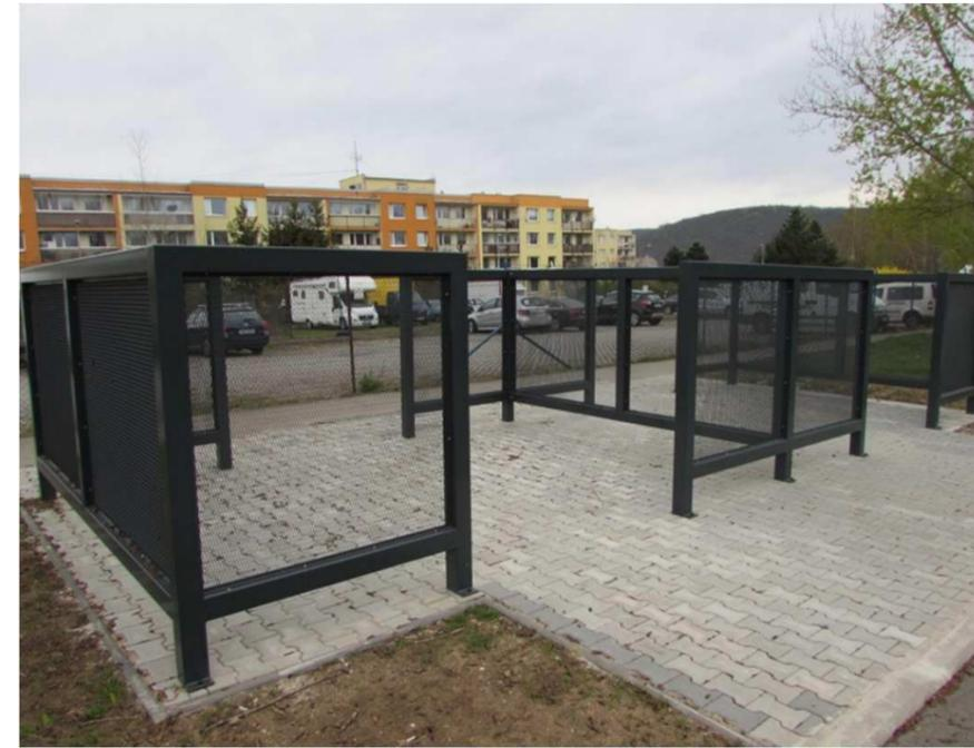
Řešení nových paravánů na odpad – ocelová konstrukce, zastřešení dřevěnou prgolou
